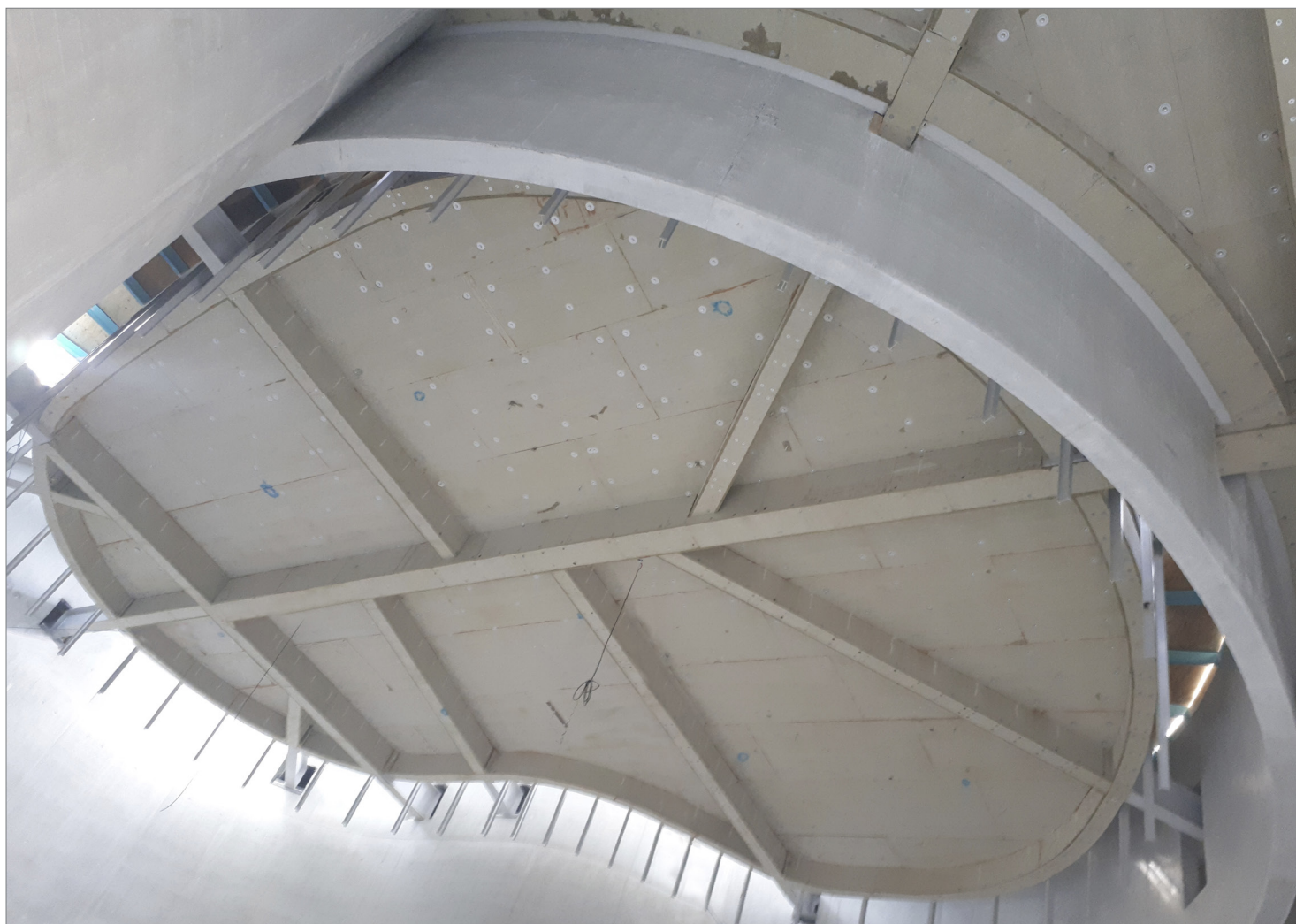
Det frithængende loft, formet som en bønne
